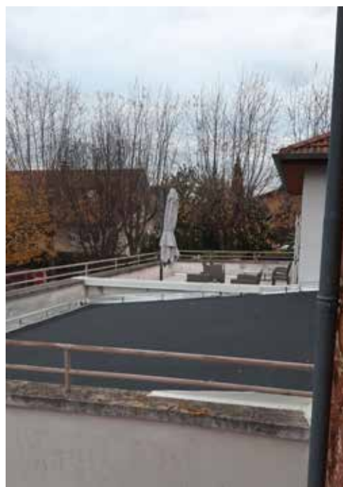
Toit du local technique
